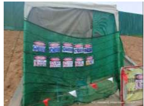
การกั้นพื้นที่และติดตั้งป้ายเตือนบริเวณบ่อรับ-บ่อส่ง
