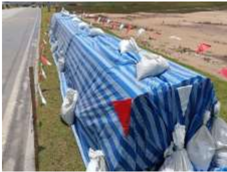
ภาพที่ 2-28 การเตรียมพื้นที่ และจัดเก็บท่อส่งก๊าซธรรมชาติ
