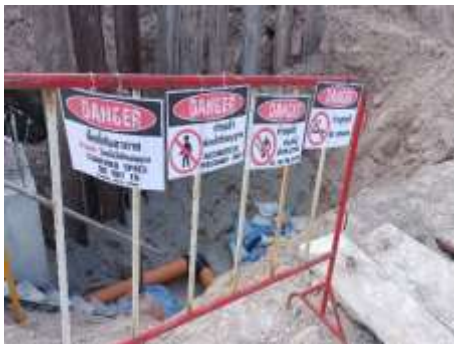
การกั้นพื้นที่และติดตั้งป้ายเตือนบริเวณบ่อรับ-บ่อส่ง
