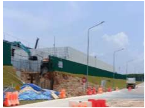
ภาพที่ 2-4 การขุดเปิดหน้าดินเฉพาะบริเวณก่อสร้าง
