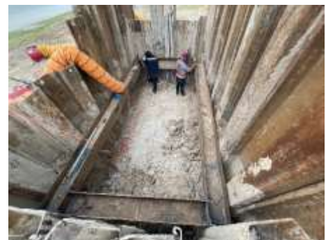
ภาพที่ 2-13 การติดตั้งอุปกรณ์ป้องกันดินถล่ม ได้แก่ Sheet Pile
