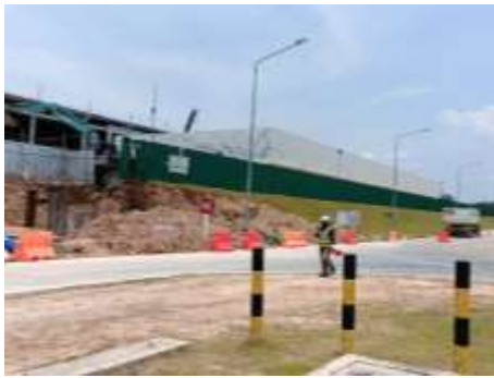
ภาพที่ 2-4 การขุดเปิดหน้าดินเฉพาะบริเวณก่อสร้าง
