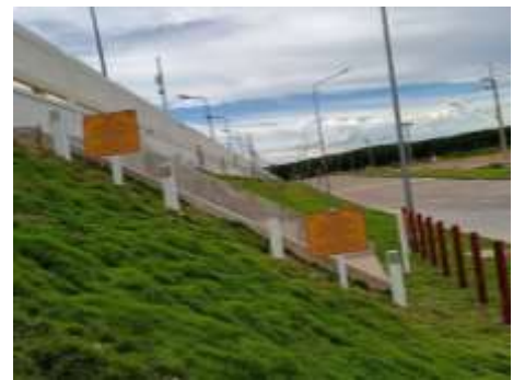
ภาพที่ 2-12 การติดตั้งป้ายเตือนและสัญลักษณ์แนววางท่อส่งก๊าซธรรมชาติ
