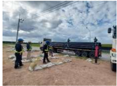
ภาพที่ 2-28 การเตรียมพื้นที่ และจัดเก็บท่อส่งก๊าซธรรมชาติ
