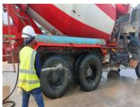
การทำความสะอาดและล้อรถก่อนออกจากเขตพื้นที่ก่อสร้าง
