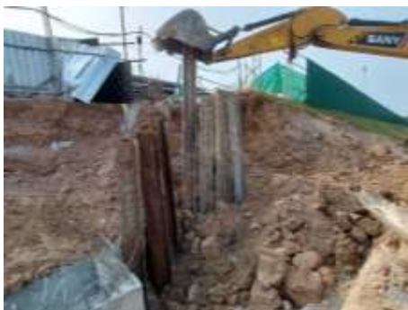
ภาพที่ 2-13 การติดตั้งอุปกรณ์ป้องกันดินถล่ม ได้แก่ Sheet Pile
